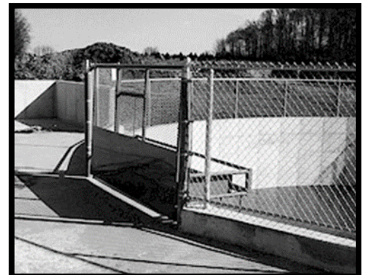
Cerca del área de empuje a la charca de estiércol y ejemplo de la elevación del borde.
